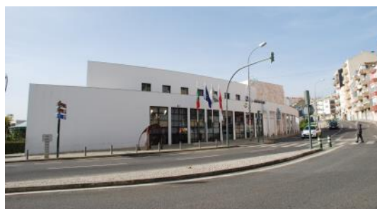
Iluminação LED, Freguesia de Encosta do Sol
